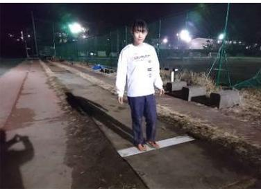
2年生の佐々木さん、千葉さんが走り高跳びで好記録を出し、新人戦でも入賞しました。来シーズンのことを考えて、また新納顧問からの要望で倉庫にあった未使用の幅跳びの踏切板を埋め込み設置しました。当初、踏切板を設置するボックスを購入することも考えたのですが、ニシで25万円もすることが判り、しかも競技場用で毎回踏切板を設置する構造です。今回は、専用の踏切板を入れるボックスを設計し、板金加工で製作しました。現役部員みんなで駐車場にあるコンクリート製の車止めをボックス周囲に埋め込み設置しました。踏切の感触は競技場に近いと好評でした。
